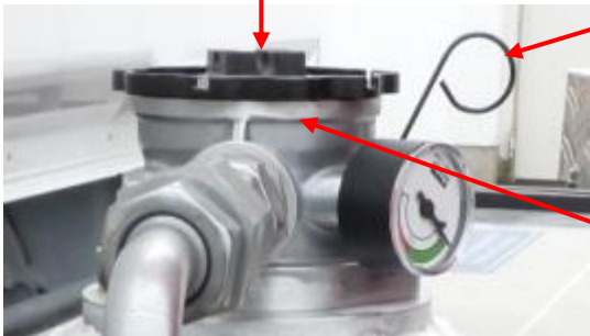
Abb. Rücklauffilter (ausstattungsabhängig)
